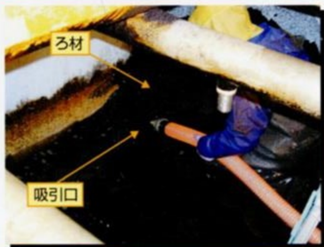
ろ材の吸引状況
